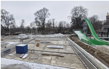
Bildunterschrift Bild 3: Von der Kiosk-Terrasse bot sich den Besucherinnen und Besuchern ein beeindruckender Blick über das Baugelände. (Foto: Stadtwerke Landsberg KU, zum Abdruck frei)
