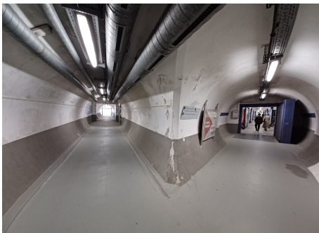
Bildunterschrift Bild 2: Blick auf die beiden Ausgangsbereiche Zentrum/Gogglgasse und Zentrum/Sparkasse, die abschnittsweise saniert werden. (Foto: Stadtwerke Landsberg KU, zum Abdruck frei)
