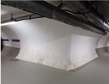
Bildunterschrift Bild 1: Sanierung der Wandflächen im Bereich des Parkdecks C zur Verbesserung von Bausubstanz und Erscheinungsbild. (Foto: Stadtwerke Landsberg KU, zum Abdruck frei)
