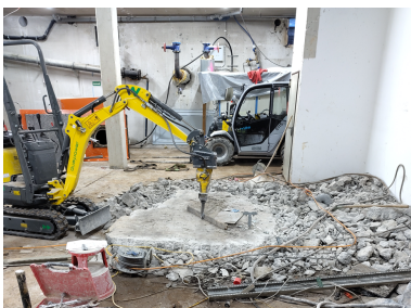
Bildunterschrift Bild 3: Im Technikkeller wird die alte Badewassertechnik Schritt für Schritt zurückgebaut. (Foto: Stadtwerke Landsberg KU, zum Abdruck frei)
