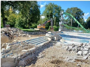
Bildunterschrift Bild 2: Das Nichtschwimmer- und Wellenbecken werden zurückgebaut und durch neue Edelstahlbecken ersetzt. (Foto: Stadtwerke Landsberg KU, zum Abdruck frei)
