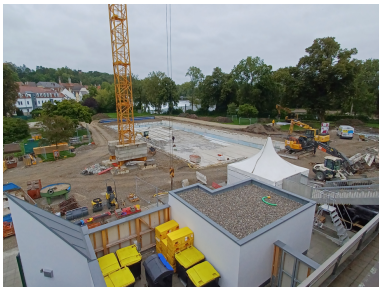
Bildunterschrift Bild 1: Ein Überblick zeigt die ersten Baufortschritte im Rahmen der Sanierung des Inselbads. (Foto: Stadtwerke Landsberg KU, zum Abdruck frei)
