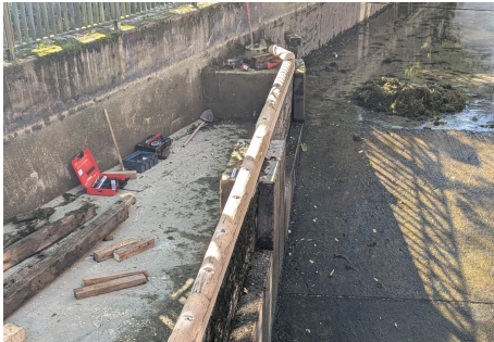
Bildunterschrift Bild 2: Instandhaltungsarbeiten im trockengelegten Mühlbach in Landsberg am Lech. (Archivfoto: Stadtwerke Landsberg KU, zum Abdruck frei)
