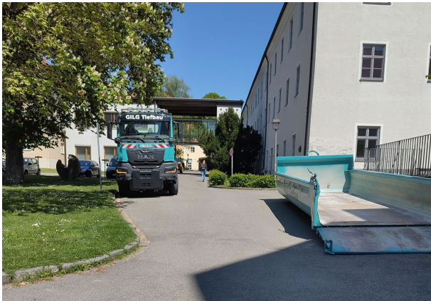
Bildunterschrift Bild 1: Baustelleneinrichtung in der Kommerzienrat-Winklhofer-Straße für den Fernwärmeausbau am Stadtmuseum in Landsberg am Lech. (Foto: Stadtwerke Landsberg KU, zum Abdruck frei)
