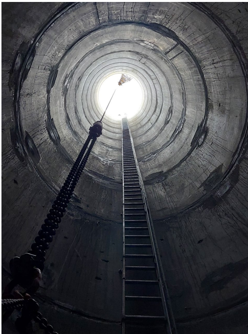
Bildunterschrift Bild 1: Blick vom unteren Bereich des Brunnenschachts des Horizontalfilterbrunnens der Stadtwerke Landsberg KU nach oben. (Foto: Stadtwerke Landsberg KU, zum Abdruck frei)
