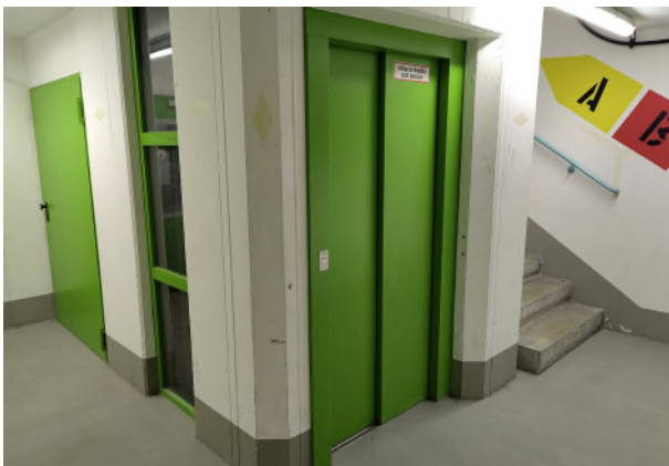
Bildunterschrift Bild 3: Zum Abschluss führen die Stadtwerke Landsberg KU die Instandsetzung des inneren Aufzugs 2 am Ausgang Hofgraben in der Parkgarage Schlossberg durch. (Foto: Stadtwerke Landsberg KU, zum Abdruck frei)
