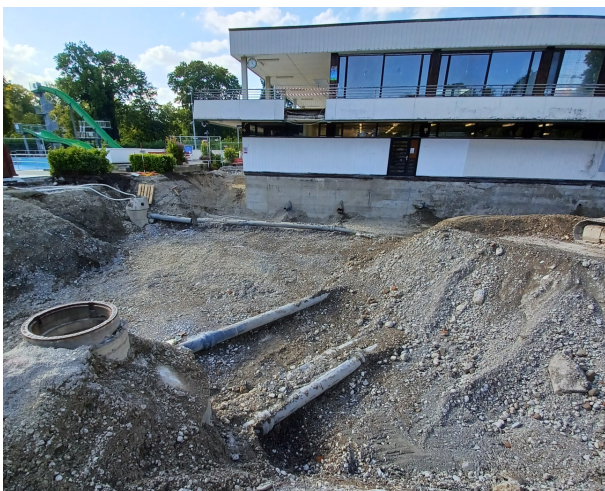
Bildunterschrift Bild 1: Der Aushub für den neuen Technikeller im Inselbad Landsberg am Lech. (Foto: Stadtwerke Landsberg KU, zum Abdruck frei)
