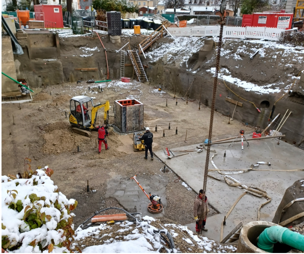
Bildunterschrift Bild 2: Vorbereitende Maßnahmen für die Bodenplatte des neuen Technikkeller im Inselbad Landsberg am Lech. (Foto: Stadtwerke Landsberg KU, zum Abdruck frei)
