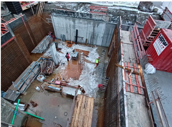
Bildunterschrift Bild 3: Die Wände des neuen Technikkeller im Inselbad Landsberg am Lech werden betoniert. (Foto: Stadtwerke Landsberg KU, zum Abdruck frei)
