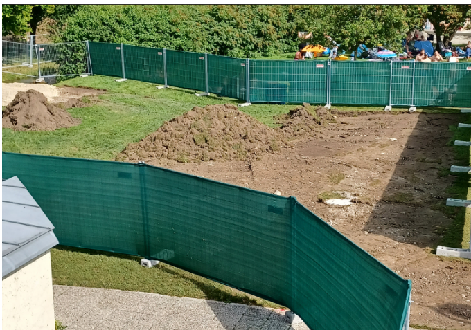
Bildunterschrift Bild 2: Einrichtung der Baustelle während des Badebetriebs. (Foto: Stadtwerke Landsberg KU, zum Abdruck frei)
