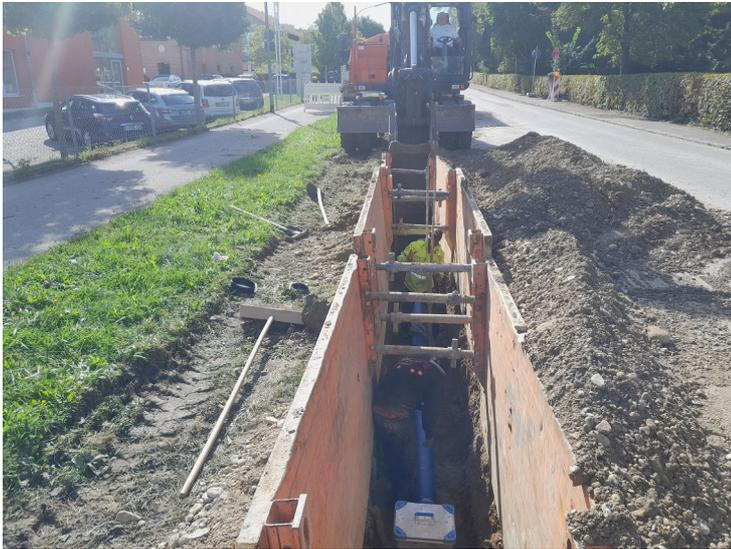
**Bildunterschrift:** Blick in den Leitungsgraben: In der Epfenhauser Straße haben die Stadtwerke Landsberg 380 Meter der Trinkwasserhauptleitung erneuert. Ab Donnerstag fließt der Verkehr wieder ohne Einschränkungen in beide Richtungen. (Foto: Marco Sonnleitner; zum Abdruck frei)
