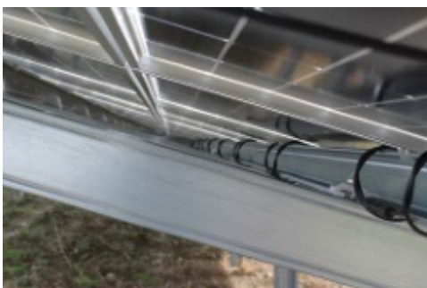
Bildunterschrift Bild 03: Seitenansicht eines bifazialen Solarmoduls. (Foto: Stadtwerke Landsberg KU, zum Abdruck frei)
