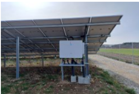
Bildunterschrift Bild 02: Einer von 18 Wechselrichtern für die Energieerzeugung der PV-Anlage. (Foto: Stadtwerke Landsberg KU, zum Abdruck frei)
