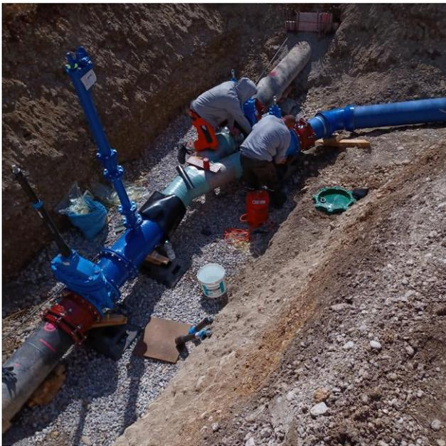
**Bildunterschrift:** Die Stadtwerke Landsberg bauen einen neuen Horizontalfilterbrunnen in Landsberg. Auf dem Foto schließen zwei Mitarbeiter die neue Verbindungsleitung an ein Y-Stück an. Durch diese Anschlussleitung soll der neuen Brunnen mit dem bestehenden Trinkwassernetz verbunden werden. (Foto: Stadtwerke Landsberg KU, zum Abdruck frei)
