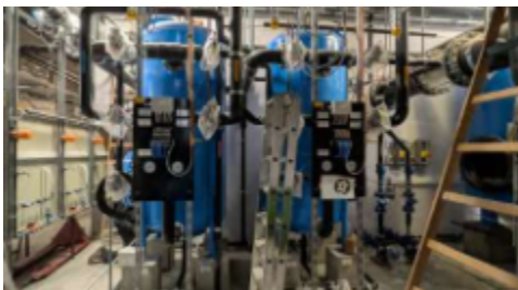
Bildunterschrift Bild 5: Eine moderne Filteranlage reinigt das Rückspülwasser, bevor es in die Kanalisation gelangt – ein umweltfreundlicher Ersatz für das bisherige Verfahren. (Foto: Stadtwerke Landsberg KU, zum Abdruck frei)
