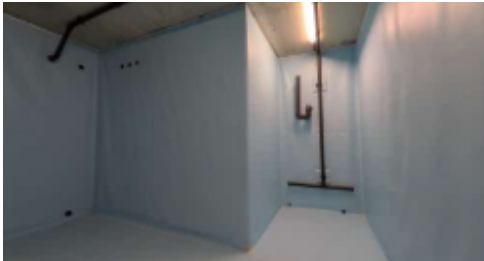
Bildunterschrift Bild 4: Die Wasserbehälter für Schlamm-, Rückspül- und Schwallwasser wurden installiert und mit spezieller Folie dauerhaft wasserdicht ausgekleidet. (Foto: Stadtwerke Landsberg KU, zum Abdruck frei)
