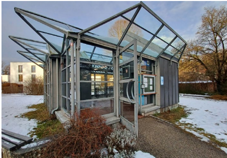
Bildunterschrift Bild 2: Aufzugshäuschen Mühlbachweg/Brudergasse: Der Aufzug wird auf den neuesten technischen Stand gebracht, um Sicherheit und Verfügbarkeit langfristig zu verbessern. (Foto: Stadtwerke Landsberg KU, zum Abdruck frei)
