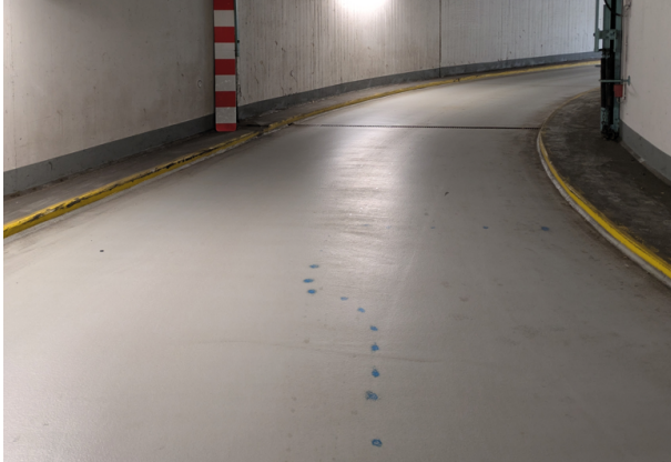
Bildunterschrift Bild 2: Auch im Bereich der Ausfahrt werden Risse im Bodenbelag saniert – diese Arbeiten erfolgen einmalig in einer Nachtaktion. (Foto: Stadtwerke Landsberg KU, zum Abdruck frei)
