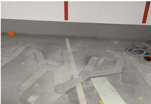
Bildunterschrift Bild 2: Nach dem Schleifen ist die Fläche optimal vorbereitet. Im nächsten Schritt wird grundiert, eventuell bandagiert und anschließend die Verschleißschicht aufgetragen. (Archivfoto: Stadtwerke Landsberg KU, zum Abdruck frei)
